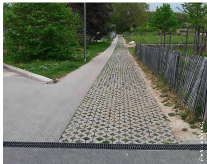
Chemin piétonnier à double revêtement (Meyrin) : un revêtement plat offrant un grand confort de marche peut être combiné avec une désimper-méabilisation
