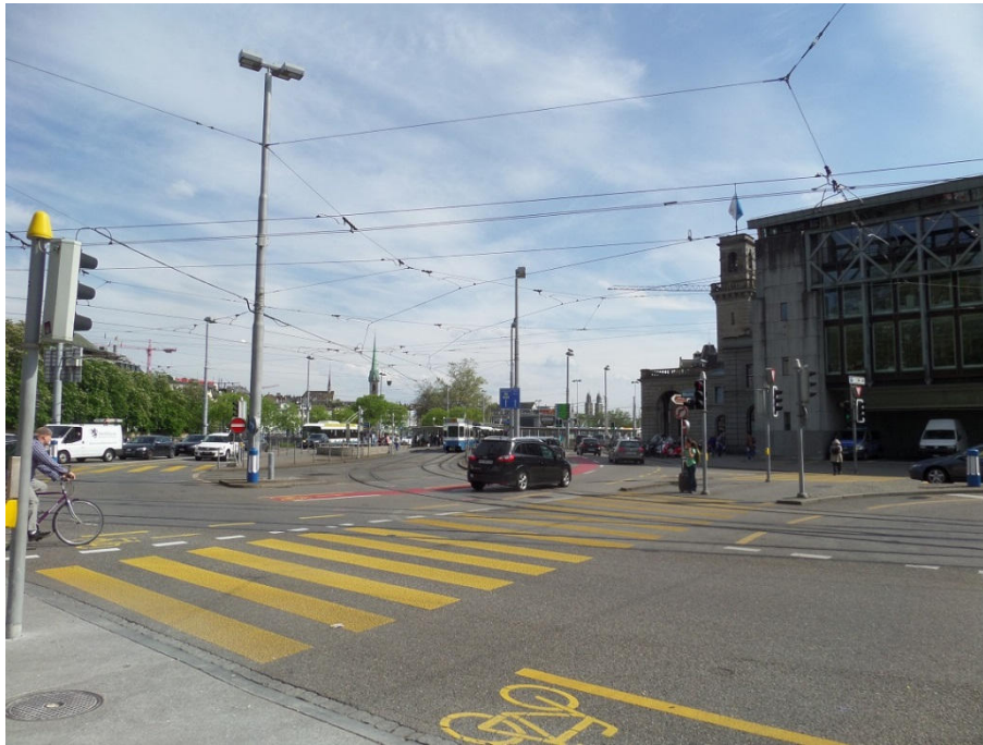
Bild 26: Querung Museumstrasse, Zürich: nur teilweise befriedigende Dauer der Rot- und Grünphasen
