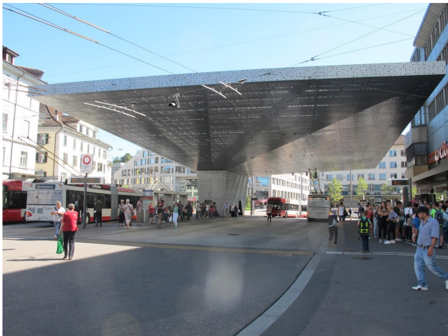
Bild 38: Bahnhof Winterthur: vorbildlich neu gestaltet
