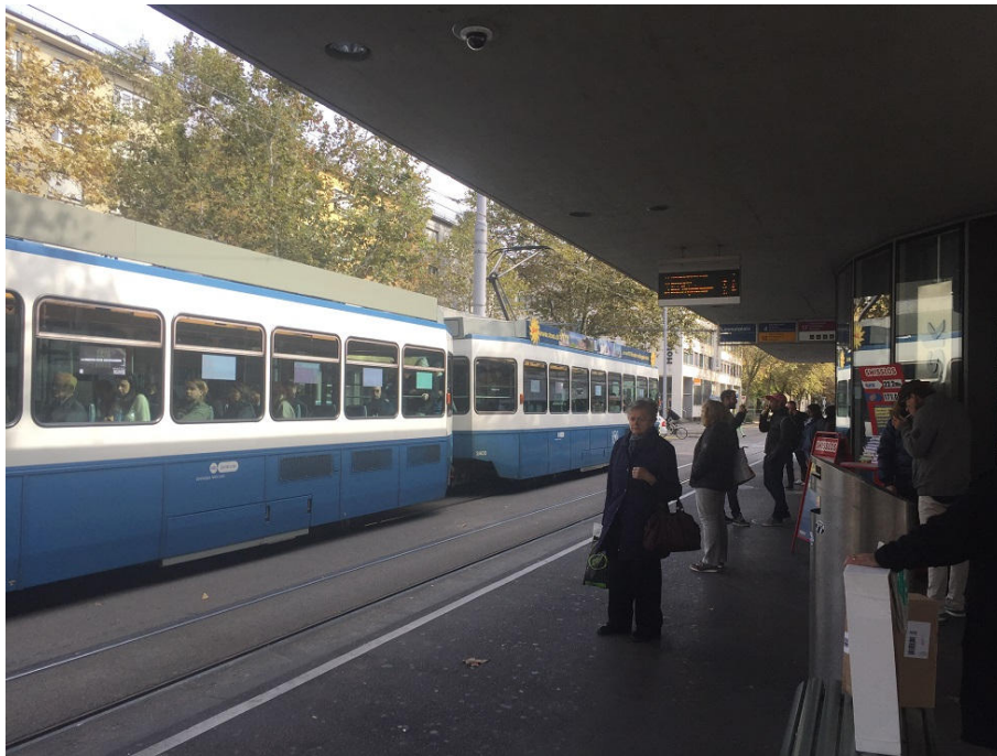
Bild 39: Haltestelle Limmatplatz, Zürich: genügend Warteraum, erhöhte Haltestellenkante
